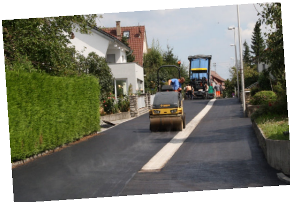
SANIERUNG DER MÖRIKESTRASSE
